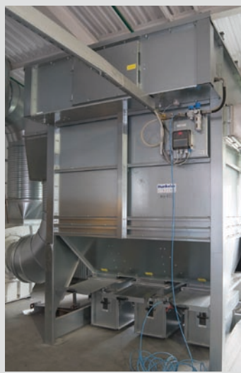
Все прессы для высадки и другое оборудование подключены трубопроводами к системе аспирации компании Hunkeler Systeme: отходы собираются, удаляются и прессуются автоматически
