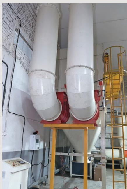
В новом цехе смонтирована современная автоматизированная система аспирации бумажных и картонных отходов
