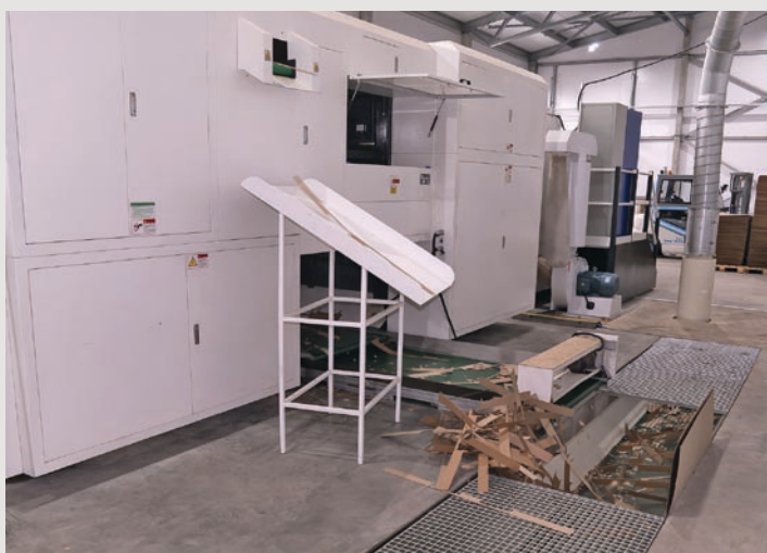
Облой из пресса для высечки автоматически отправляется в систему аспирации по специальному ленточному транспортеру, встроенному в пол цеха еще на этапе проектирования здания
